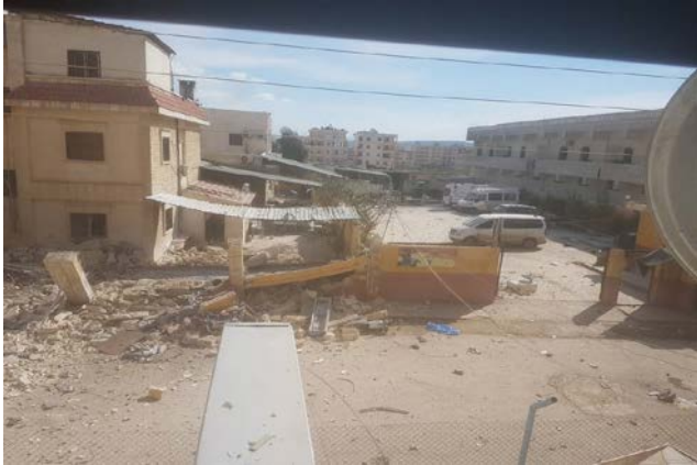
5 Distruzione dell'ospedale "Avrin" dopo il bombardamento di artiglieria il 16.03.2018
